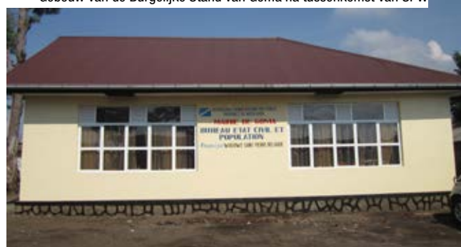
Gebouw van de Burgelijke Stand van Goma na tussenkomst van SPW
