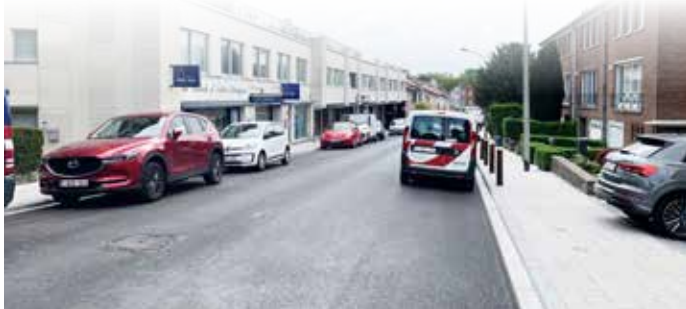
Travaux d'asphaltage terminés rue du Bemel.
