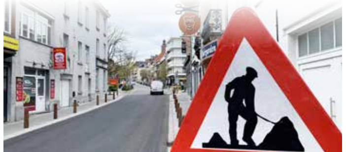
Travaux d'asphaltage rue Louis Thys.
