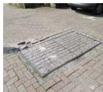
Devra-t-on attendre la rénovation de la place des Maieurs pour pouvoir y marcher en sécurité?
