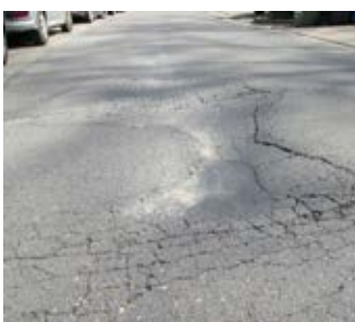
Faiencement et enfoncement d'un revêtement asphaltique. Faute d'intervention, il faudra demain refaire complètement cette chaussée.
