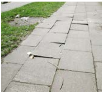
Dalles de trottoir descellées, qu'attend-on?
