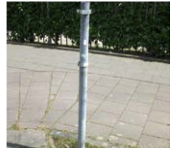
Depuis plus d'un an ce poteau s'ennuie de ne plus servir à indiquer le début d'une piste cyclable... un détail parmi d'autres!
