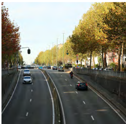
TRAVAUX/WERKEN TUNNEL MONTGOMERY MONTGOMERYTUNNEL
